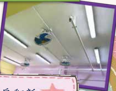
走廊牆身及風扇翻新
