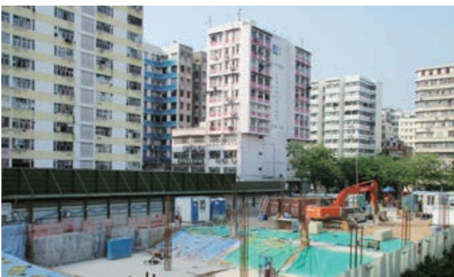
▲ 深水埗區議會保良局石硤尾社區服務中心建築地盤 - 2016年8月。 The construction site of the Sham Shui Po District Council Po Leung Kuk Shek Kip Mei Community Centre in August 2016.
